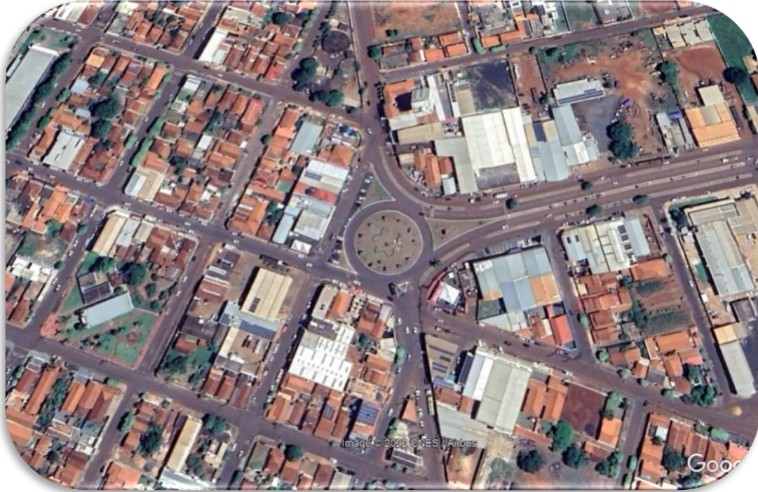
Figura 5.19 – Rotatória na situação na Avenida Leocádio de Souza Reis
