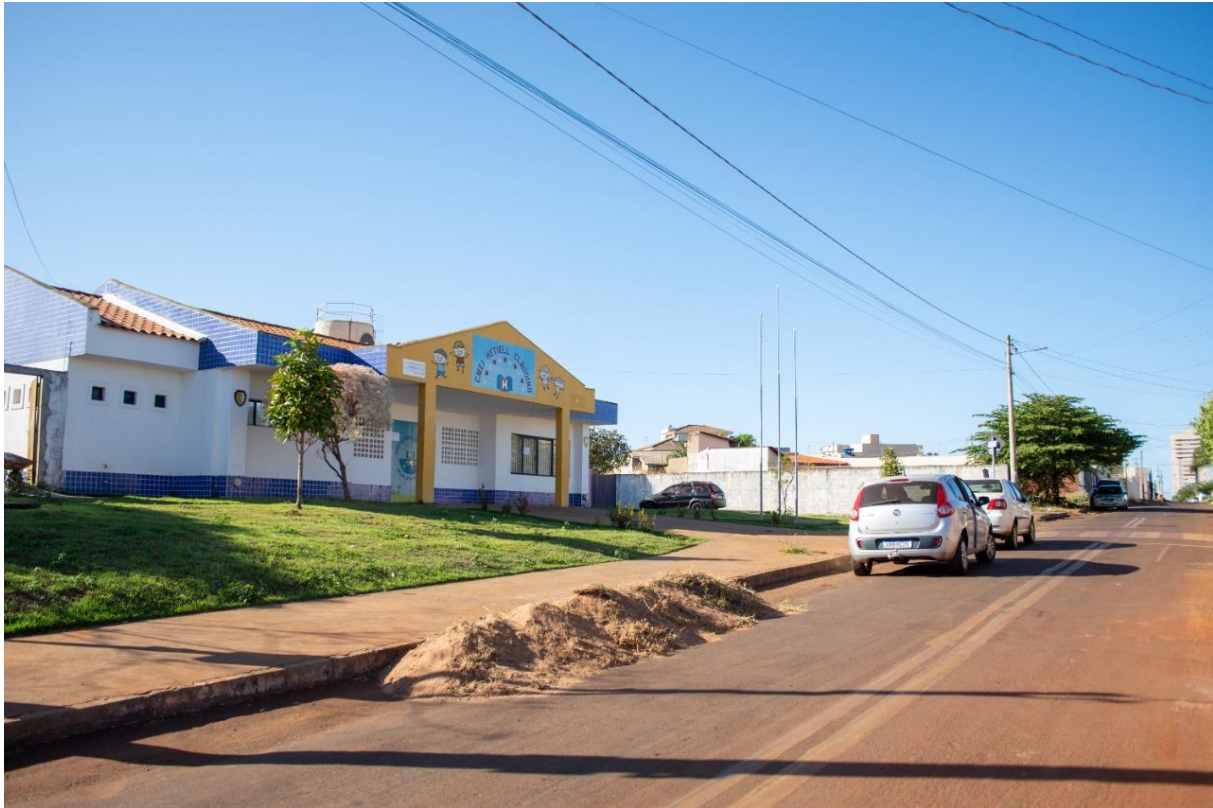
Figura 5.78 – Vista do entorno atual da CMEI Hetiell. Espaço árido com pouca arborização no passeio, sem faixa elevada de segurança e sem espaço de convivência para os Pais, Alunos e Professores.
