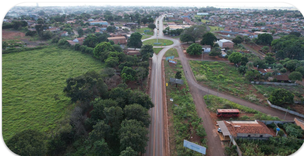
Figura 5.22 – Acesso ao município de Quirinópolis pela GO-206.
