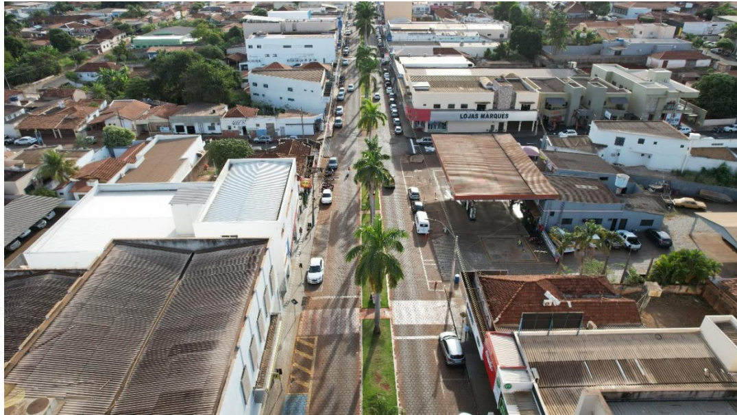
Figura 5.8 - Avenida Brasil vista aérea.
